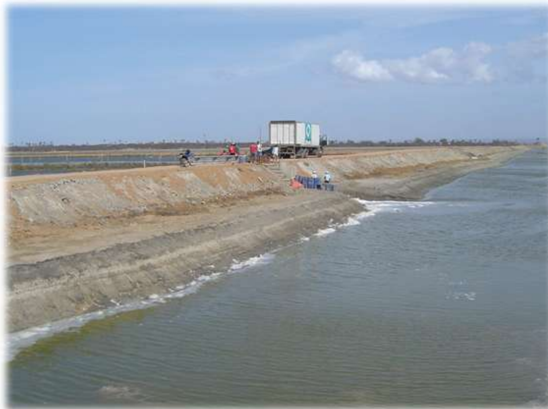
INFRA-ESTRUTURA INTERNA CANAL DE DESPESCA
