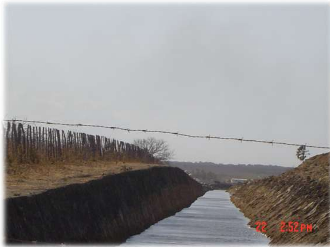
INFRA-ESTRUTURA INTERNA CANAL DE DESPESCA II
